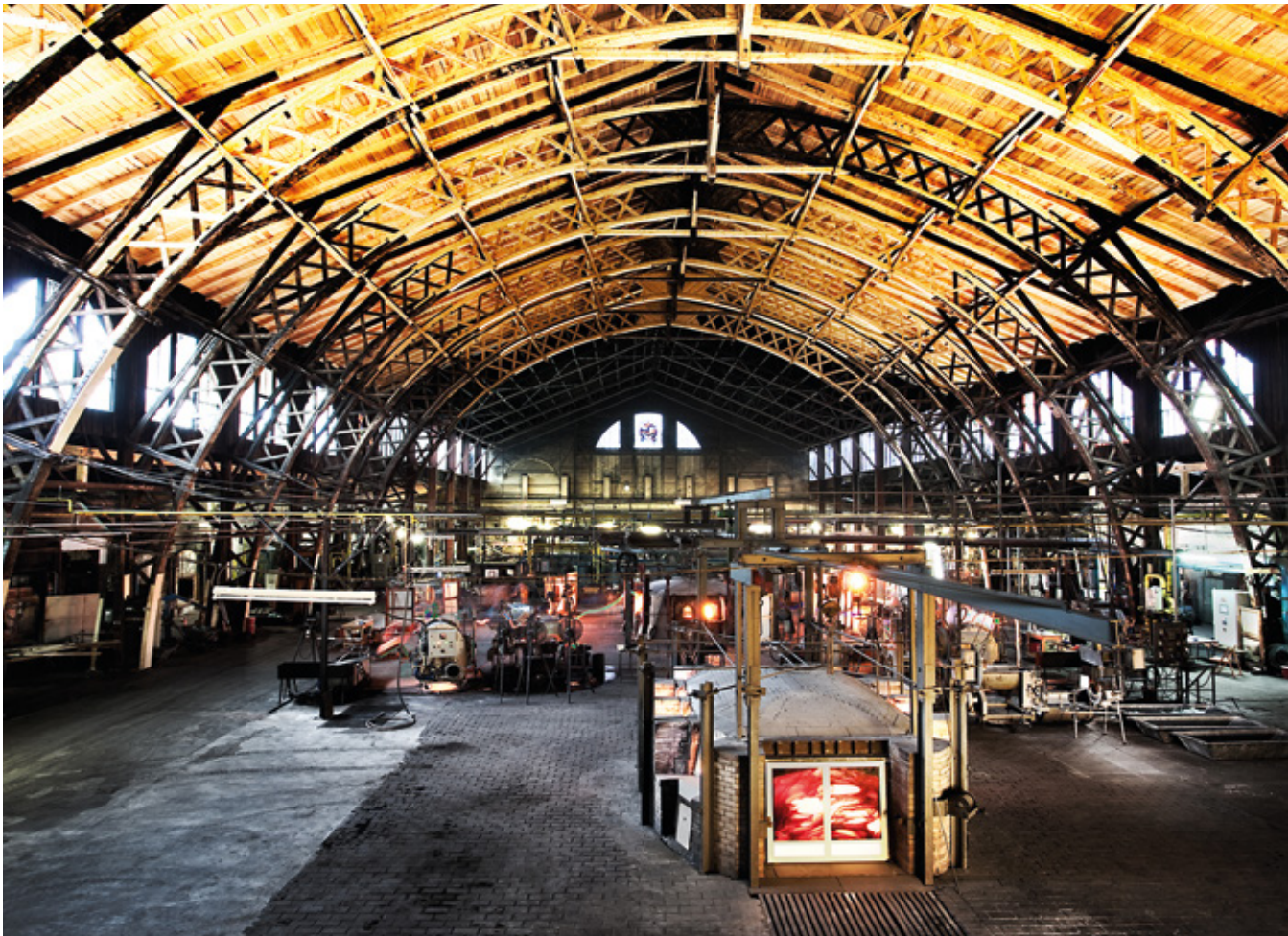
Blick in unsere 1906 erbaute historische Ofenhalle.
