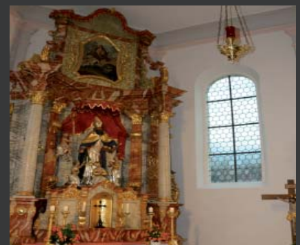
Filialkirche St. Nikolaus, Wolfsbach/Bayern; restauro®IR als Wabenverglasung zum Schutz des barocken Altars aus dem 18. Jahrhundert; Einbau 2016
